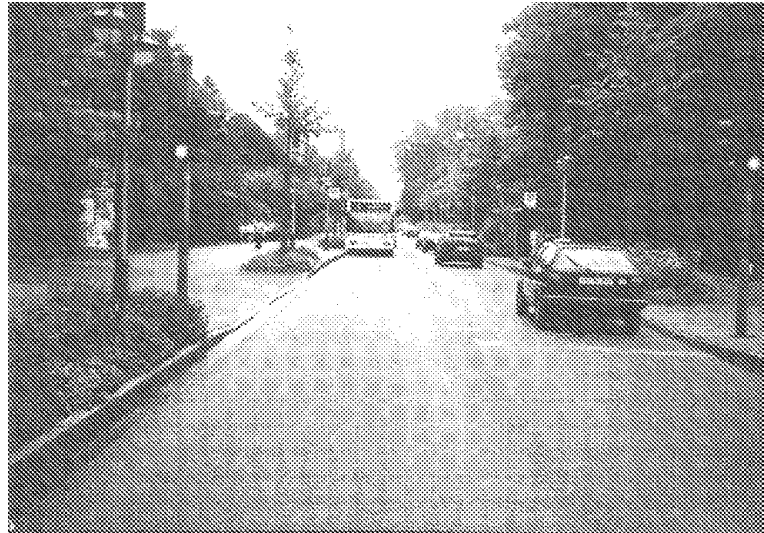
Abb. B22: Macht auch große Verkehrsmengen stadtverträglich; städtebaulich integrierter Straßenbau in der Philippsruher Allee, Kesselstadt.
