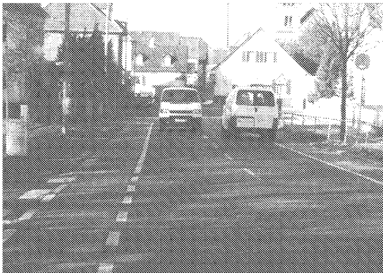
Abb. B52: Markiert als Radfahrstreifen, benutzt als Angebotsstreifen; Obergasse, Klein-Auheim.
